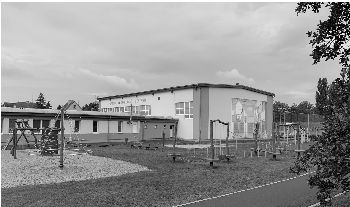
tělocvična a jednopatrové křídlo se šatnami, jídelnou a kuchyní
